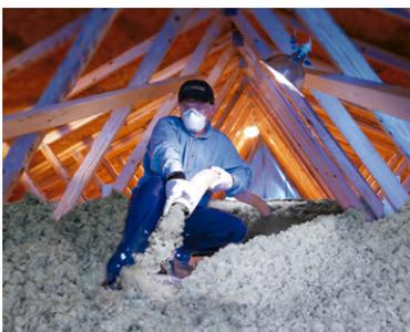
La aplicación en falsos techos y buhardillas es similar. En el caso de falsos techos se insufla el material en la cámara con el mismo procedimiento que en fachada. Y en el caso de buhardillas se insufla el material en menor densidad desde el interior de la buhardilla con un espesor previamente especificado para conseguir la resistencia térmica deseada.
